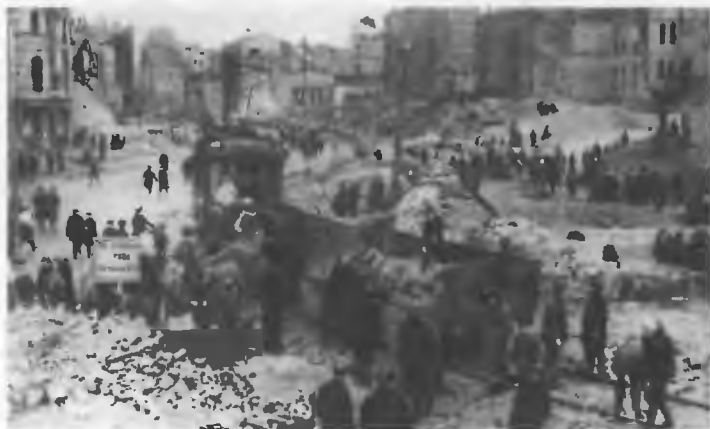
Киевляне на восстановлении разрушенного войной Крещатика.
